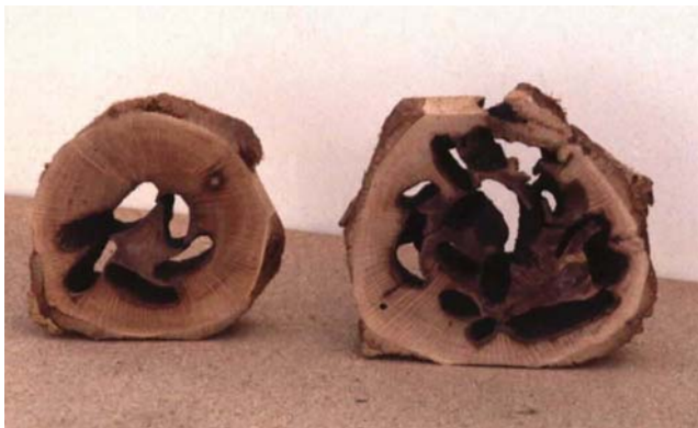
Figura 4.- Daños del Cerambyx en la madera.
